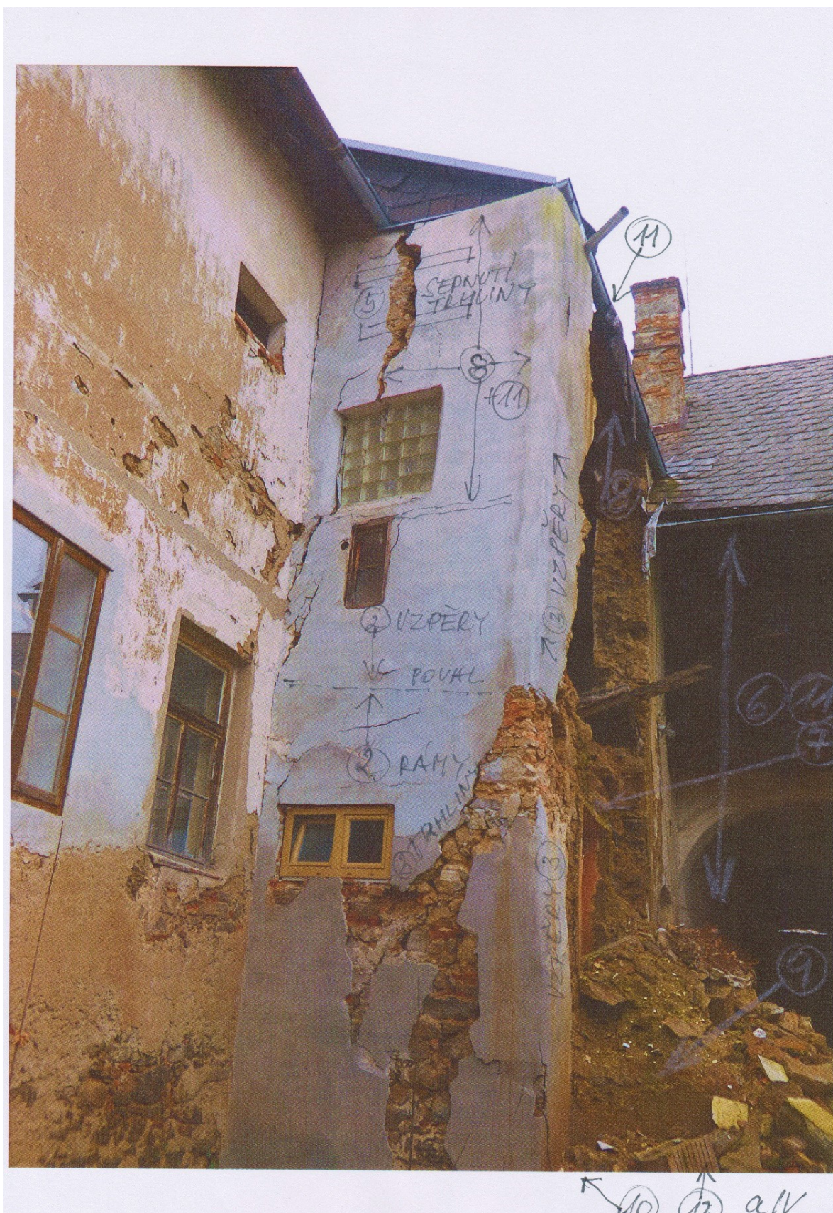
aIV, A1 - postup zajištění
